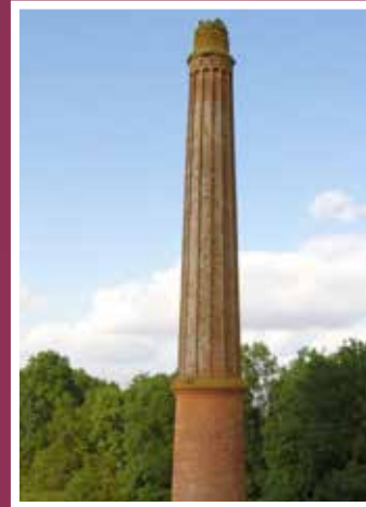
▲ La grande cheminée, dernier vestige du four Hoffmann.
