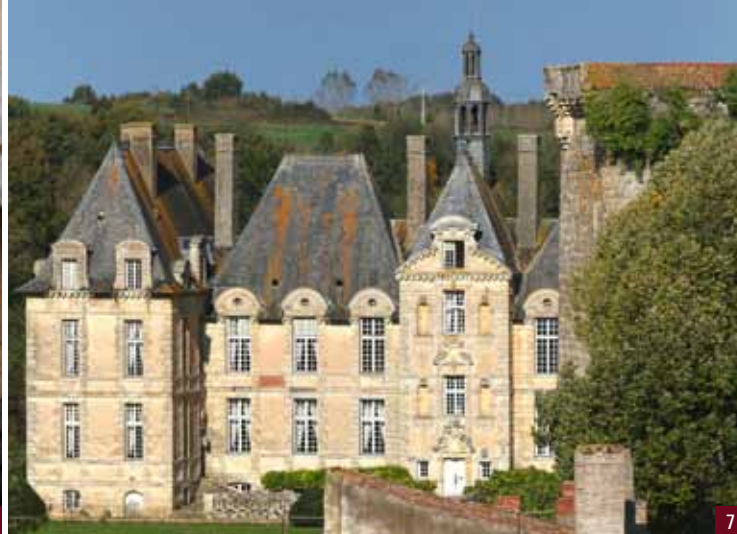
7. La façade principale du château et le donjon
